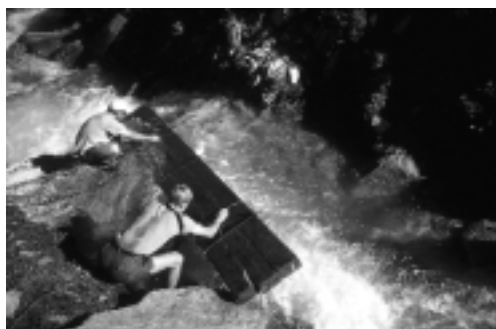
Pralognan (73) - Récupération de la passerelle de Rosoire. © Parc national de la Vanoise - Christophe Gotti
