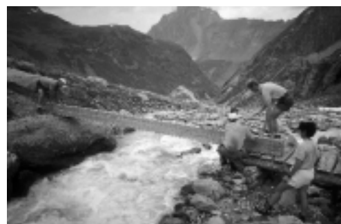
Les Allues - Réserve naturelle du Plan de Tuéda - Mise en place de la passerelle de Gébroulaz par les gardes-moniteurs du PNV. © Parc national de la Vanoise - Christophe Gotti
